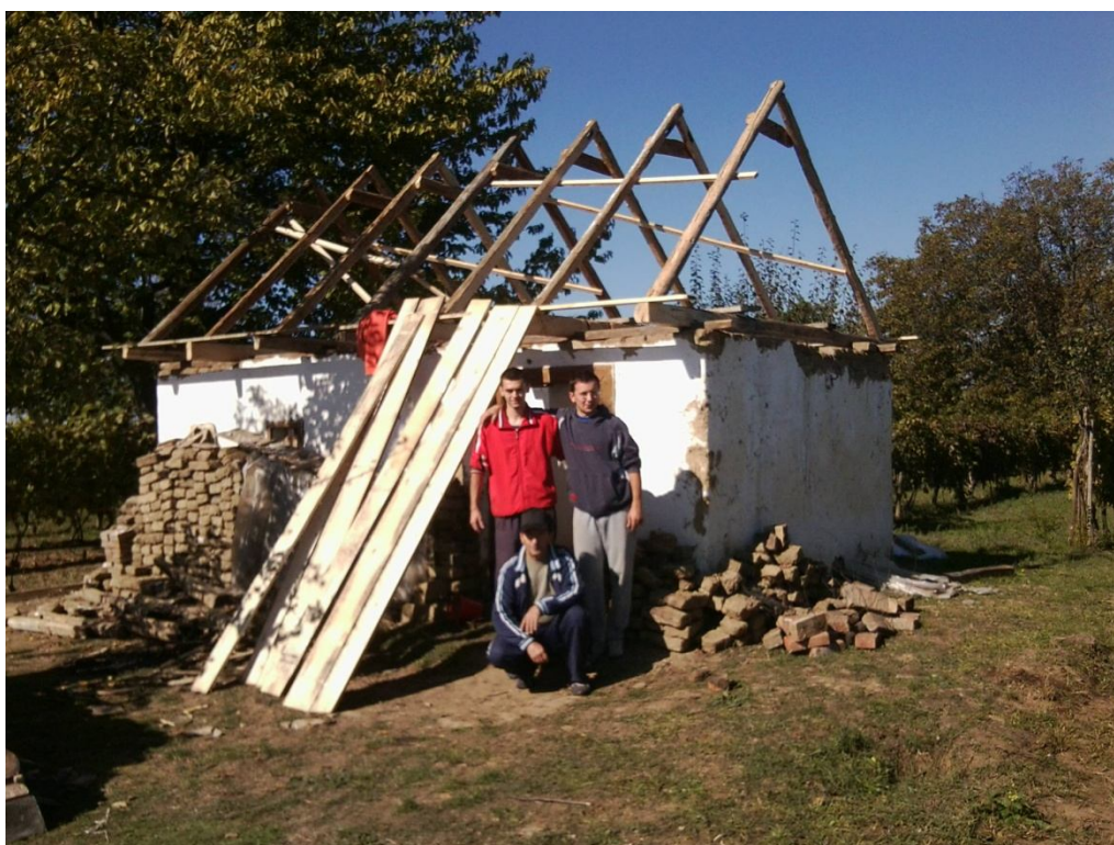
2. Nakon malo rušenja i dosta prašine, nova krovna konstr. 10.2011.
